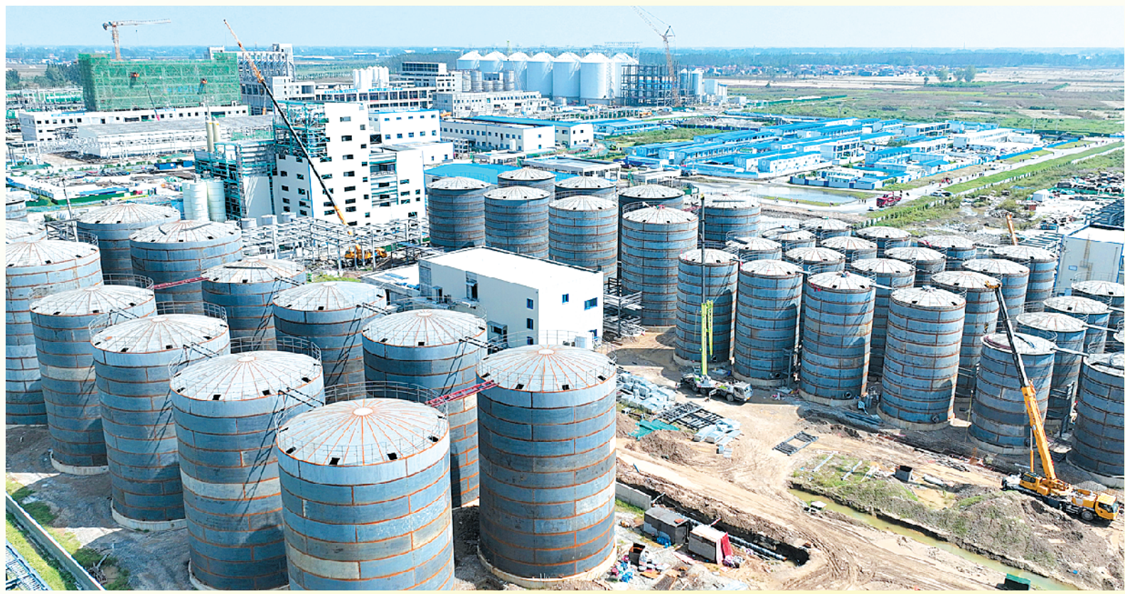
今年以来,周口临港开发区全面落实市委、市政府决策部署,坚持“临港新城、开放前沿”发展定位,充分发挥比较优势,持续抓项目、优环境、促投资,增动能,高质量发展态势稳中向好。图为益海生物年加工20万吨玉米胚芽项目建设现场。 记者宋风 通讯员赵磊摄
