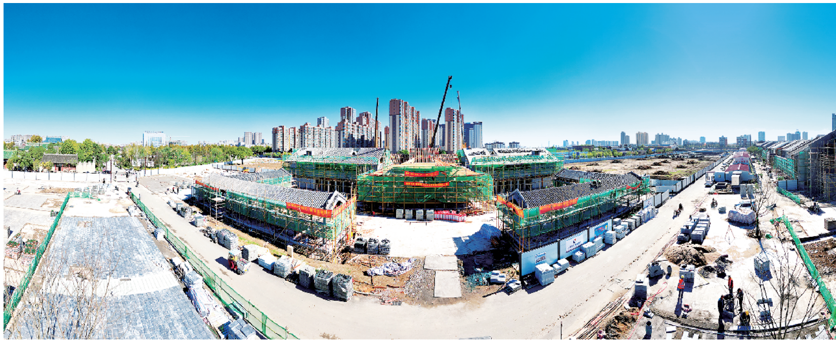
经过4个多月的建设,关帝庙历史街区城市更新改造项目的重要组成部分——关帝戏台已然成型。图为施工现场。
