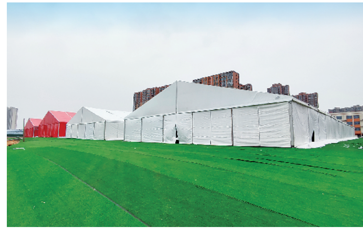
第三板块展销大篷已经完工。
