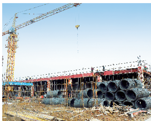
商水县皓晨纺织服装配套项目(新开工)。
