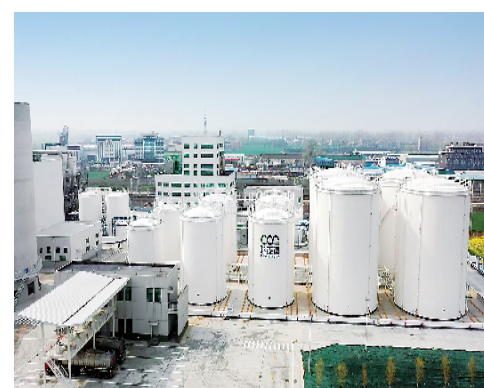
河南瑞茂通粮油有限公司植物蛋白项目(投产)。
