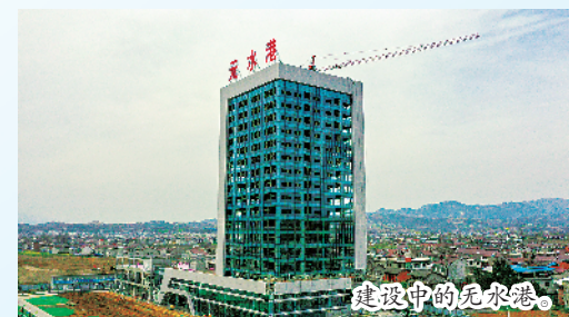
建设中的无水港。
