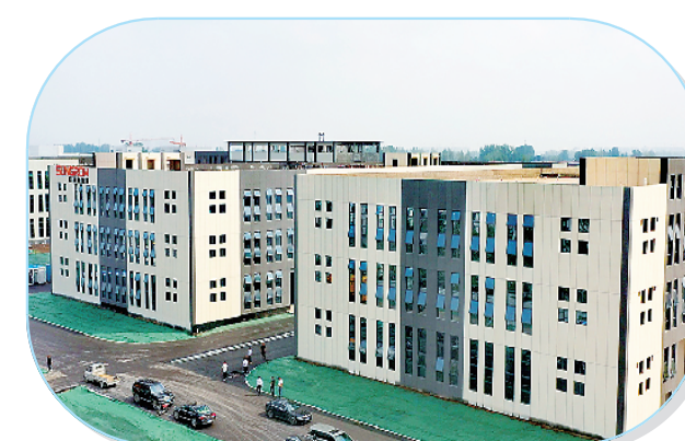
河南培阳科技发展有限公司阳光零碳装备制造产业项目。
