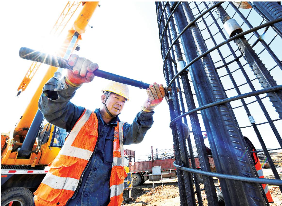
10月27日，工人在绑扎钢筋。连日来，工人们在周口港中心作业区进行打桩作业，为建设港口码头打好基础。据了解，位于商水县黄寨镇王潭村和小集村的周口港中心作业区未来将建设22个泊位，当前建设的一期工程将建设13个泊位。
